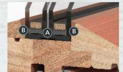
Durchwurffhemmende Verglasung (A) der Klasse P4A nach DIN EN 356. Die Verklebung mit Hochleistungs-Polymerkleber (B) sichert die Scheibe gegen gewaltsames Entfernen aus dem Flügelrahmen.
